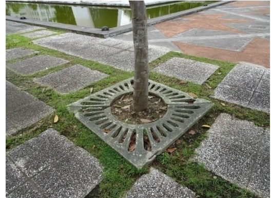
Gambar 12 : Tree grating yang digunakan mampu untuk membantu pengawalan akar pokok daripada tumbuh ke dasar permukaan. Sumber : JPBW
