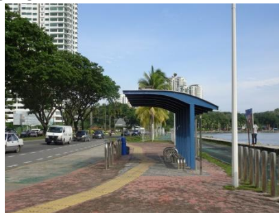
Gambar 13 : Kemudahan guiding blocks berkesinambungan dari tempat perhentian pengangkutan ke Taman Awam Teluk Likas. Sumber : JPBW
