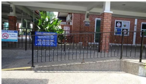
Gambar 25 :Kemudahan cecondong di Taman Perdana, Tg. Aru. Sumber: JPBW
